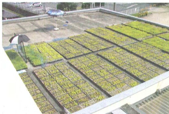
図3. 校舎の屋上緑化のため①室の上に並べたメキシコマンネングサの容器(手前)と設置していない半分から向こう側(③室の上)
