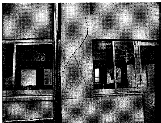
写真11 北側の1階柱のせん断破壊
